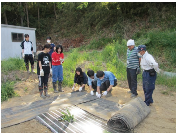
図8 防草シートの張り付け
