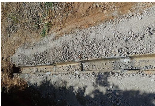
作業道路の整備 側溝の設置
