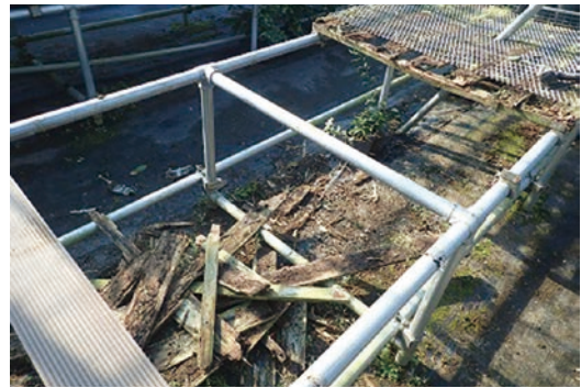
育苗ハウスの棚の修繕
