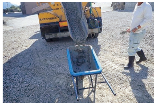
コンクリートを作業道路に打設
