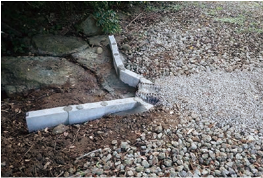
作業道路に排水用のパイプを埋設
