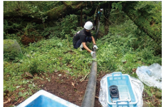
ワサビ隔離水槽への導水パイプの敷設 (有志実習)
