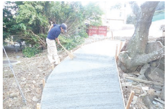
コンクリート舗装した作業道路
