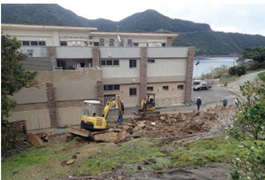
晴耕塾周りの外構工事（三純建設）
