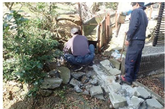
排水溝の撤去 外構工事のため
