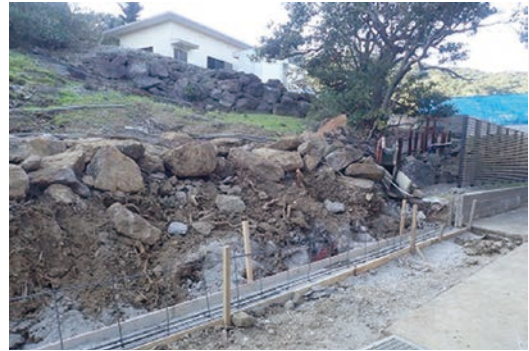
エントランス前のブロック積基礎
