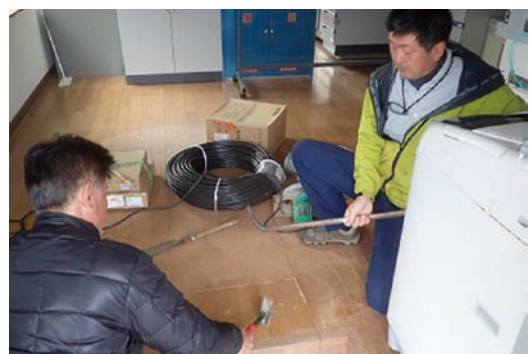
旧事務室の床の確認
