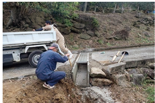
園内道路の排水対策 U字溝の設置
