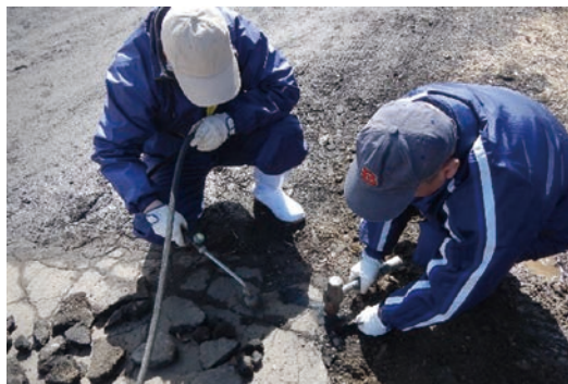
場内路面補修
