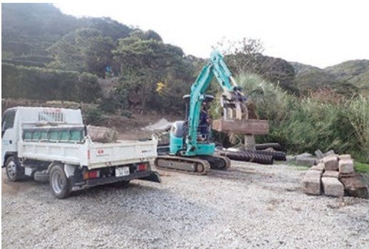
土留め用の石の運搬
