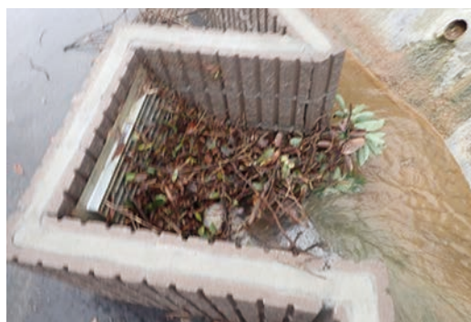
排水溝, 柵の清掃
