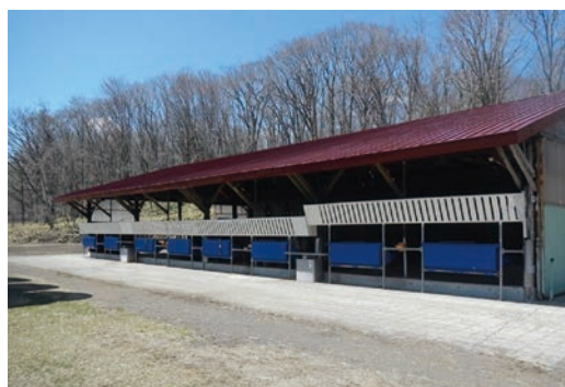
牛舎の飼槽・草架の塗装：4/30
