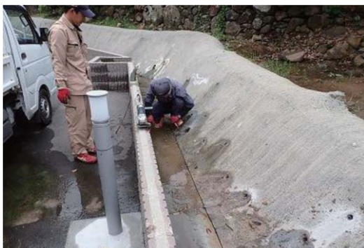
晴耕塾裏排水路の漏水補修
