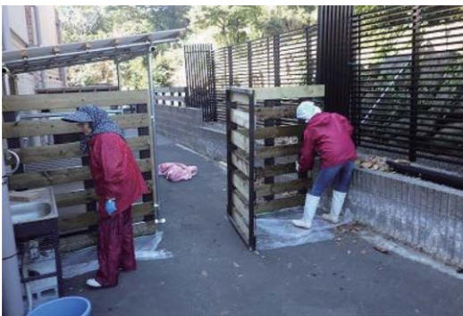
犬柵（パドック）の防腐塗装作業
