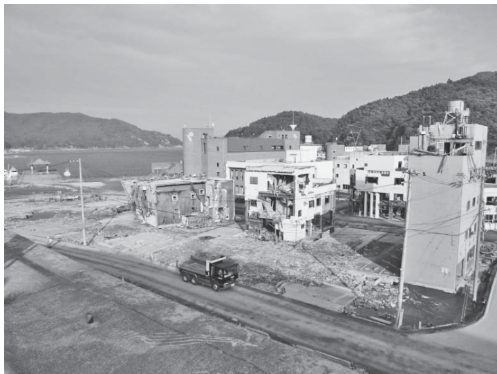
図1 津波により4階建てのビルが横倒しになった宮城県女川町の様子 (2011/7/21)
