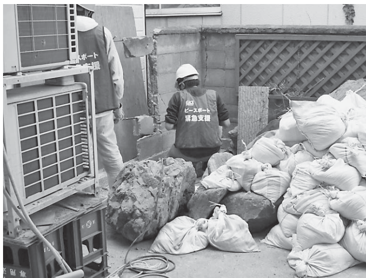
図2 地震により傾いた民家の塀を撤去する学生ボランティア (宮城県石巻市2011/7/21)
