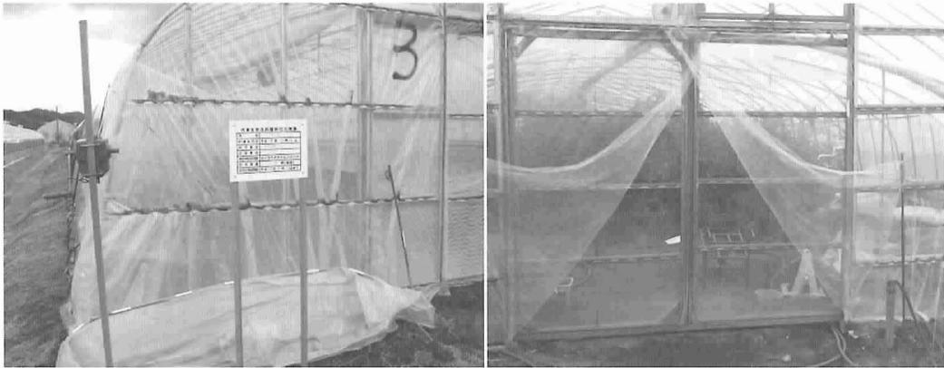
図5 法令上の「標識の掲出」によりセイヨウオオマルハナバチの利用施設ごとに掲示される許可の概要の立て札（左），出入口のネットの二重構造が保守されていない違反行為事例（右）
