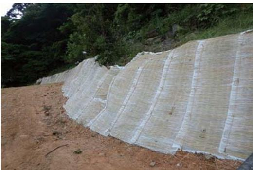
法面の崩落対策としてわら芝を施工
