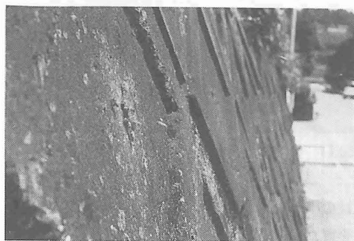
図16 コンクリート製の土留め石垣内の営巣(長崎県島原, 1986, 5)
