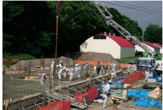
7月22日1階床打設
