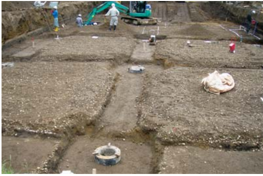
基礎部分整地
