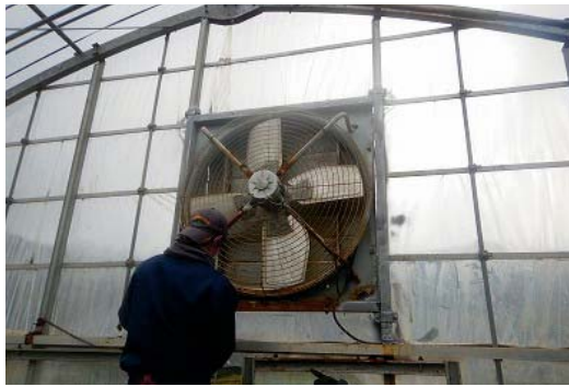
マンゴーハウス換気扇のメンテナンス
