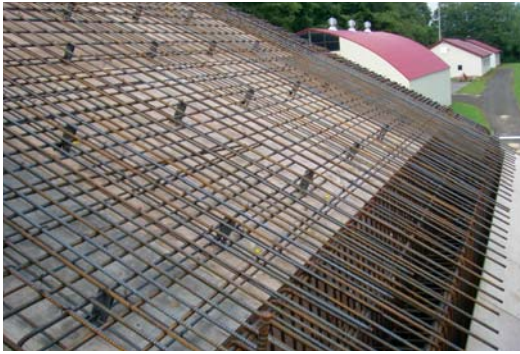
8月31日屋根鉄筋組
