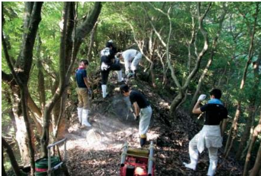
岩場を削っての階段作り
