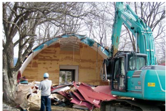
11月19日宿泊食堂棟解体（D型ハウス）
