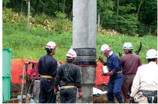
2014年6月9日16mのコンクリートパイル打ち込み (22本)
