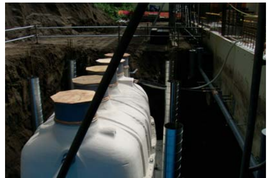
8月4日浄化槽設置
