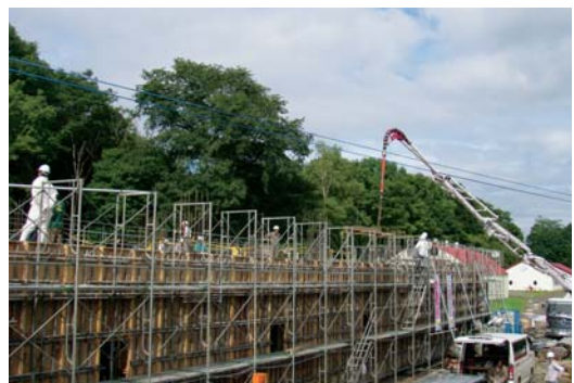
8月21日2階床打設
