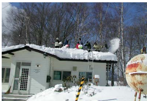
4年生有志による屋根の雪下ろし作業
