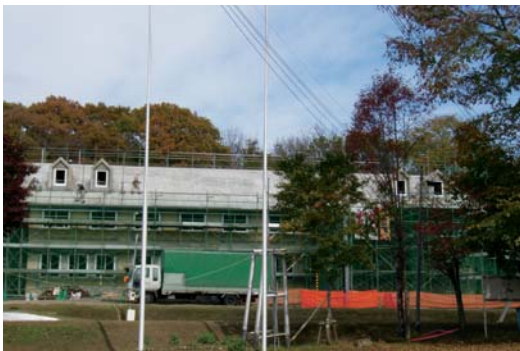
10月10日コンクリート躯体完成
