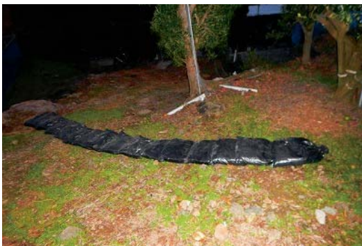
作業道路の排水対策
