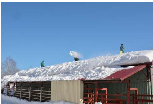
人力による除雪作業
