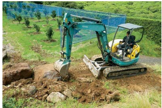
作業道路の造成
