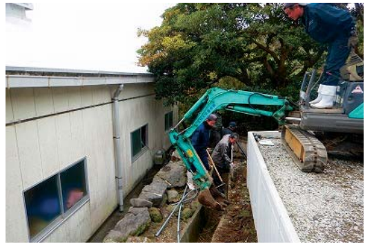
水道配管修理
