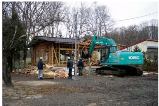
11月24日宿泊事務棟解体
