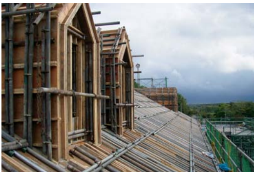
9月25日屋根打設
