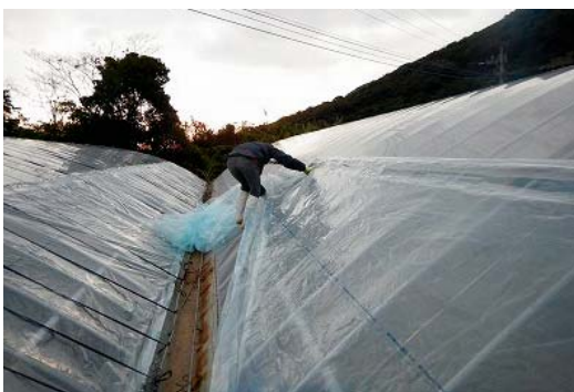
マンゴーハウス谷換気フィルムの交換
