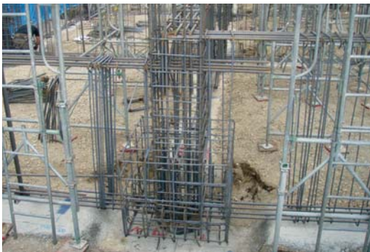
布基礎鉄筋組
