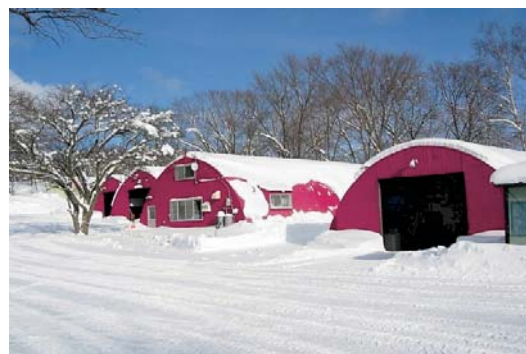
施設内除雪管理
