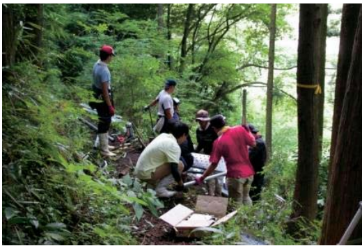
林内道へのステップの設置
