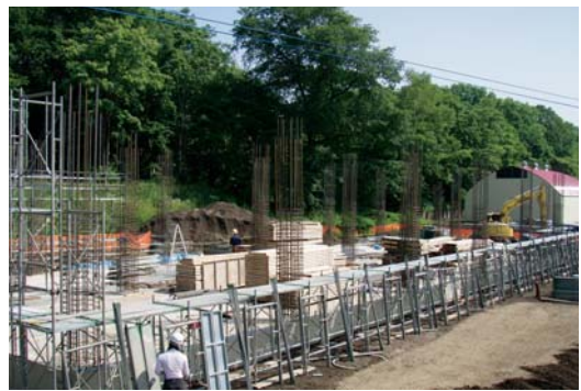
7月30日柱鉄筋組上げ
