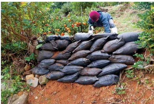
崩落箇所の補修
