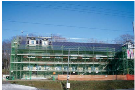
10月20日外装タイル張り
