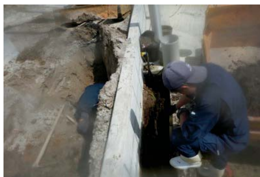
事務所横の漏水箇所、地中深く穴を掘り漏水個所を探り、配管をつなぎ直し再び舗装
