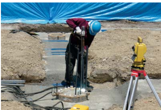
6月25日パイルに鉄筋溶接
