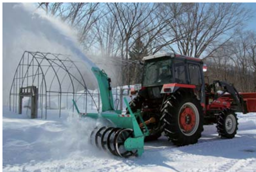
トラクターによる除雪作業
